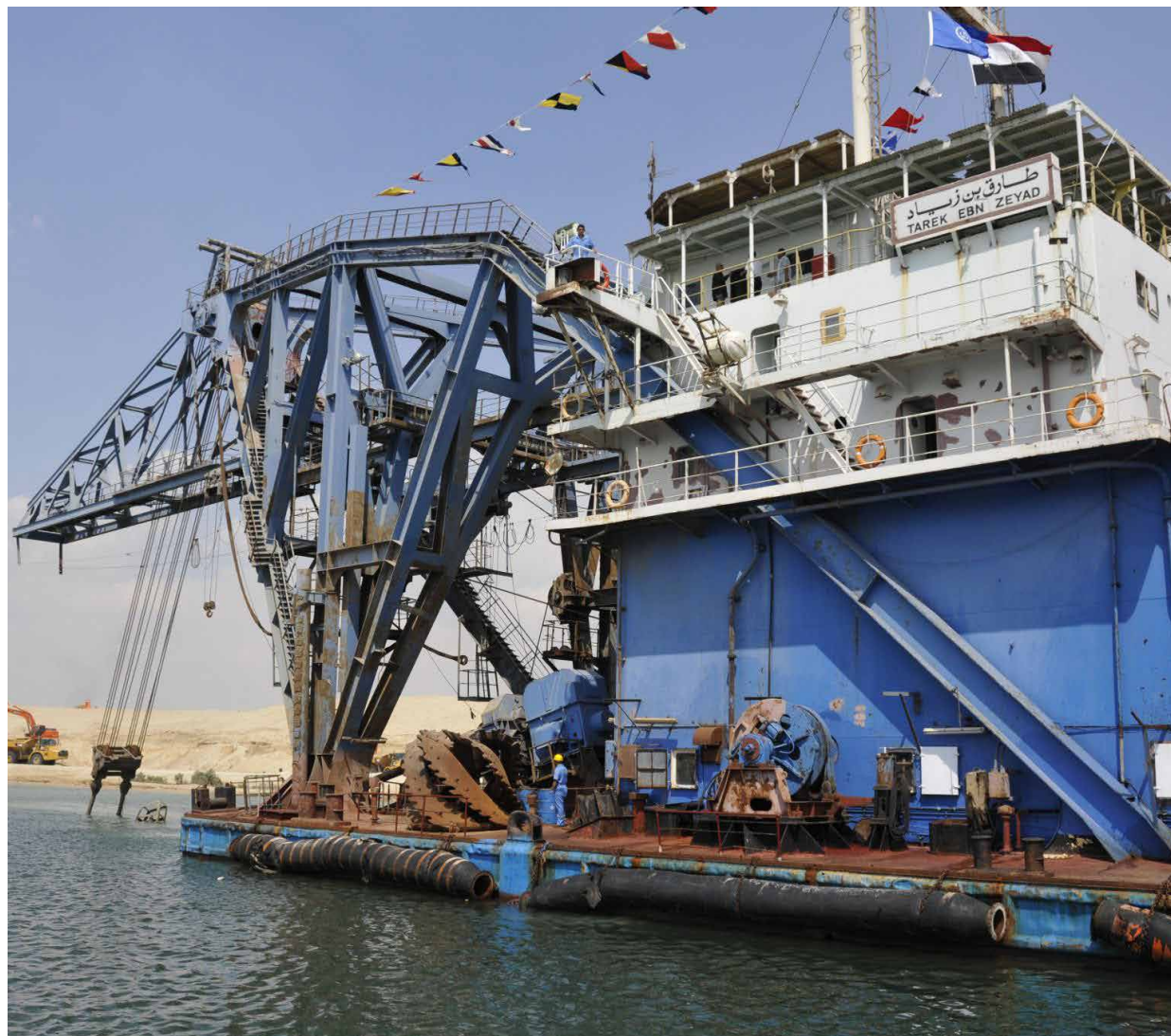
الكراكة طارق بن زياد أثناء عملها بمنطقة البلاح
